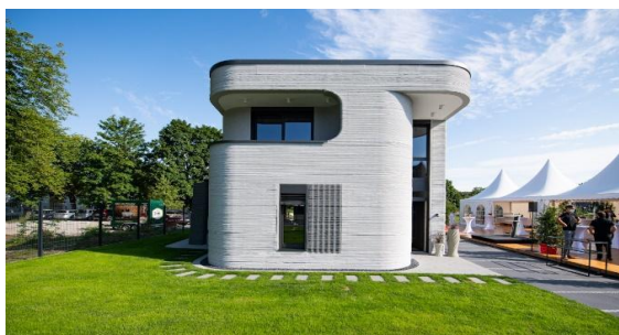
Рис. 5 – Дом изготовленный 3D принтером
