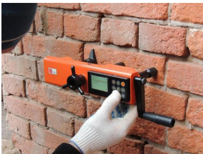
Рис. 2 – Процесс ручного обследования здания
