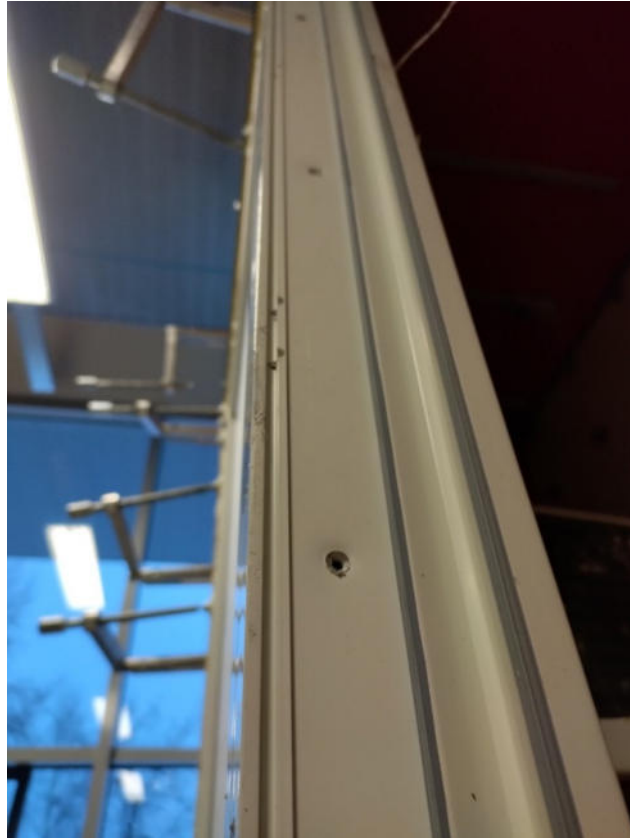
Рисунок 4.2 – Саморезы крепления ПВХ профиля импоста к армирующему сердечнику выкручены
